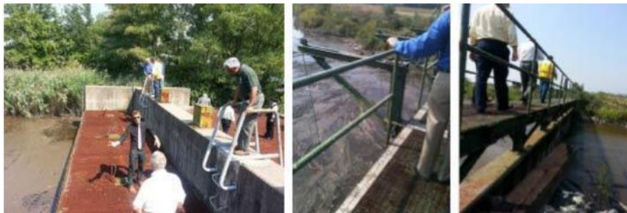
Fig. 4.1: Inspección física de la infraestructura actual de reducción de riesgos. Los equipos asignados por el NJDEP se han empeñado en clasificar el impacto del huracán Sandy en bermas, compuertas para marea e infraestructura de reducción de riesgos existente. La inspección física es crucial en la evaluación que realiza el Estado sobre la condición actual de las medidas de protección para identificar las reparaciones necesarias, así como la oportunidad de mejorarlas para abordar futuros eventos climáticos extremos y maximizar la inversión federal.
